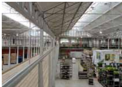
Fig. 6. Illustration d'un plancher destiné uniquement à la circulation des personnes (et donc pas considéré comme un plancher intermédiaire).
